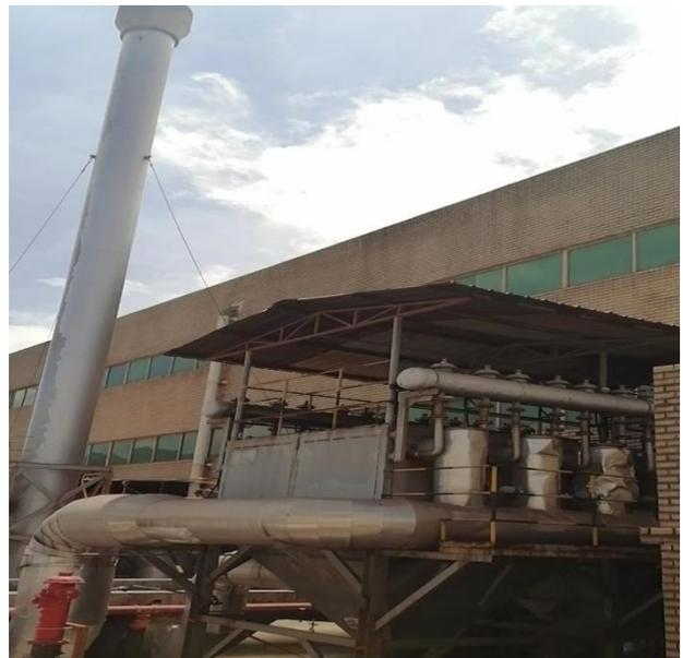
熔铸废气排气筒
